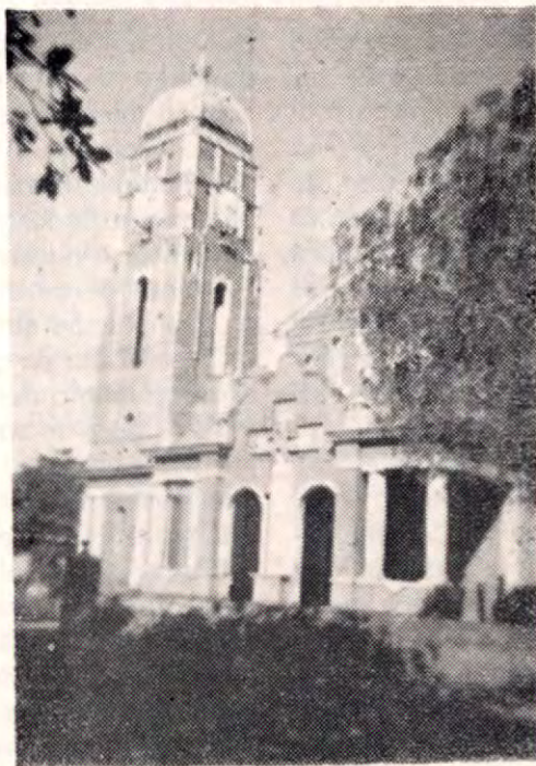
Antiguo templo de Santa Cruz de Guanacaste que acaba de ser demolido para construir uno nuevo, moderno, del cual se dejó intacta la torre del campanario.
